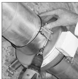
3. Befestigungsmanschetten auf beiden Seiten des Ventilators mit den Schrauben fest anziehen.
