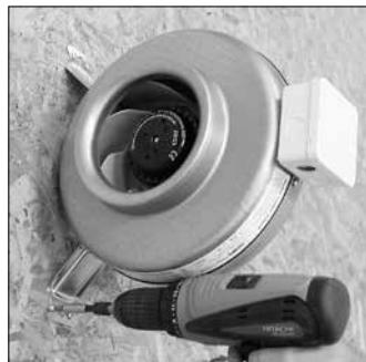
1. An der Wand oder der Decke die **A**-Maße markieren und den Ventilator festschrauben.
