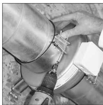
3. Spän fast montageklammer på vardera sida om fläkten med skruvarna.
