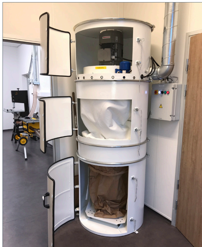
Ventilator, filter og affaldssæk.
