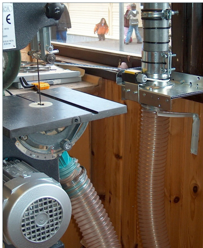
Udsugning direkte ved maskine.
